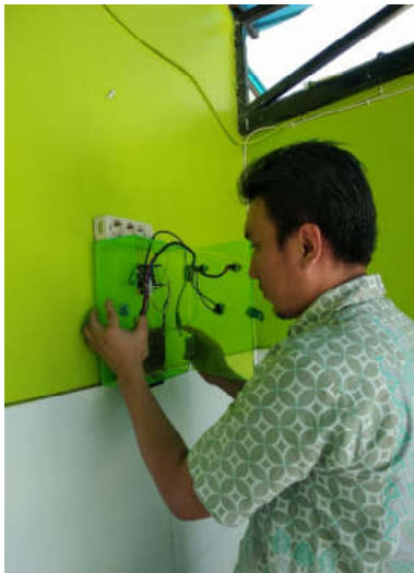
Gambar 13. Pemasangan alat wudhu otomatis di Mesjid Al Ihsan
