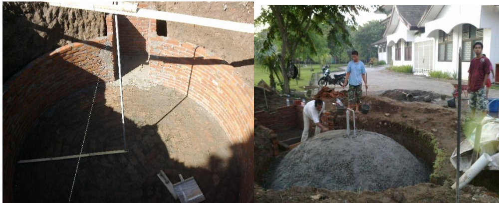
Gambar 3. (kiri) Dinding dan dasar digester; (kanan) pemlesteran kubah/dome.
