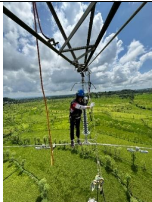
Gambar 4. Proses pemasangan isolator polimer
