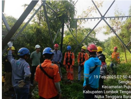
Gambar 2. Briefing sebelum memulai pekerjaan
