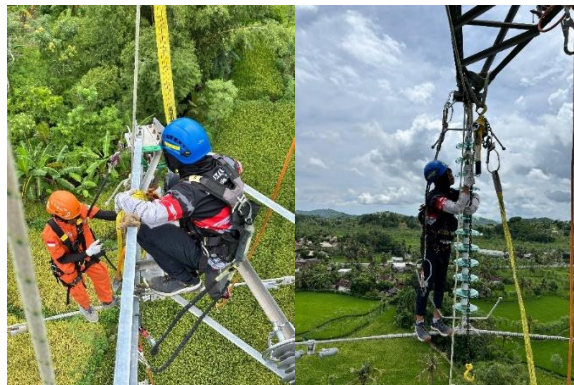
Gambar 3. Proses pelepasan isolator kaca
