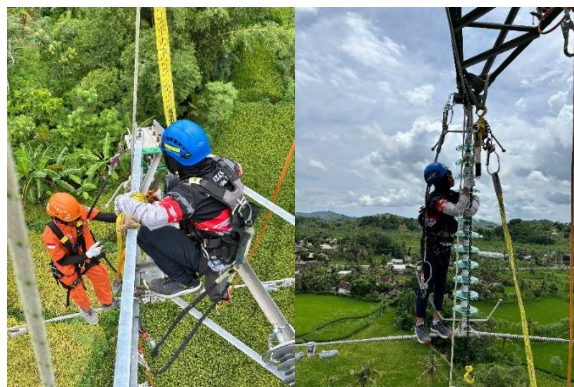
Gambar 3. Proses pelepasan isolator kaca
