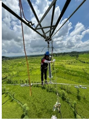
Gambar 4. Proses pemasangan isolator polimer
